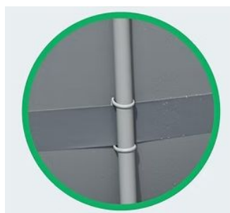
Foto 1: OK , cinta de compressão na parte interna dos postes de sustentação da piscina
